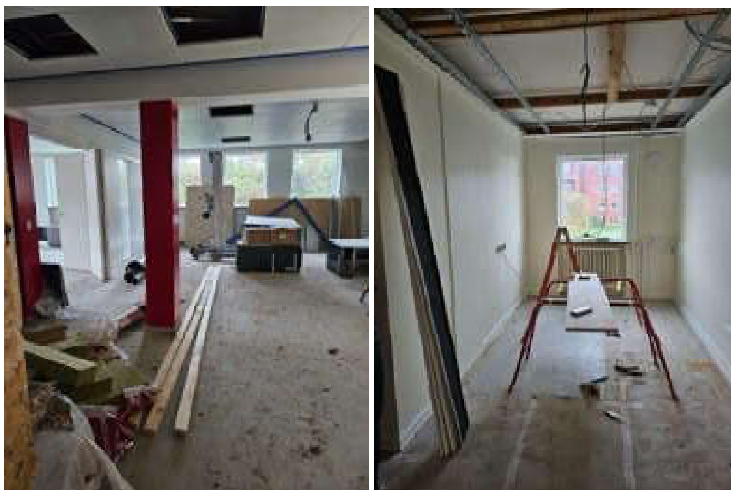
P.V. Tuxensvej 5 midt i byggerodet.
